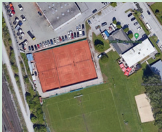
Die Anlage der ASKÖ Salzburg in Gnigl mit den 3 Freiplätzen, welche überdacht werden und dem Restaurant Bergblick (rechts unten). © ASKÖ Salzburg
