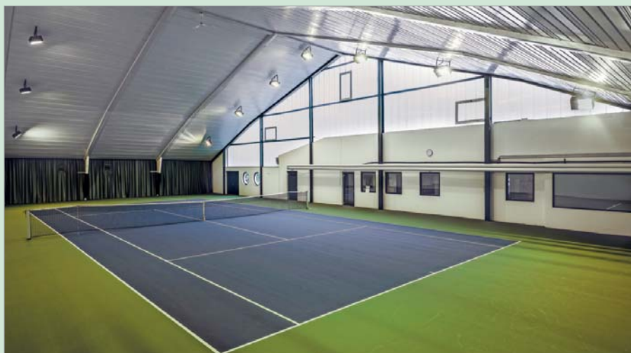
Der neue Rebound Ace Belag in der Tennishalle des Hotel Gut Weissenhof in Radstadt.
