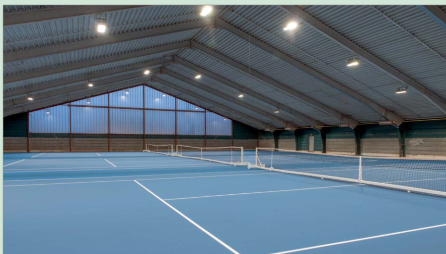
Leistungsfähige und energiesparende LED-Beleuchtung in der Tennishalle Traiskirchen.
