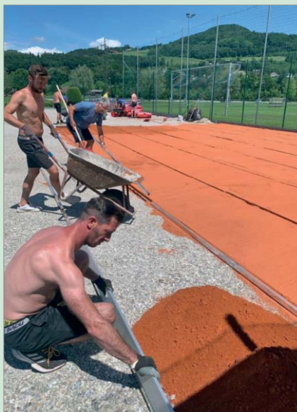
Auflage der ersten Sandschicht (40 Tonnen) am 30. Mai durch zahlreiche freiwillige Helfer. (© UTC Bergheim)
